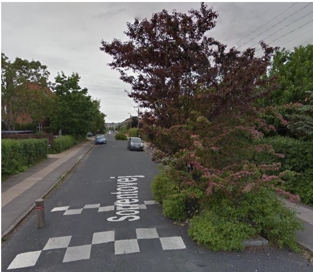
Figur 3: Vejbump ud for Sorrentovej 30/32. Bemærk at steleren mod vejbedet ikke er synlig.
