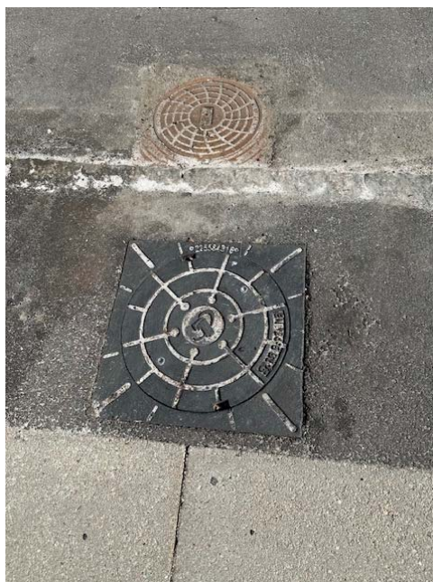
Milanovej 44: Kantsten løftes til 10 cm over vej. Brøndlåg stabiliseres.
