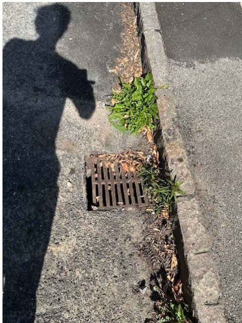
Milanovej 44: Kantsten løftes til 10 cm over vej. Brøndlåg stabiliseres.
