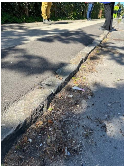
Milanovej 44: Kantsten løftes til 10 cm over vej. Brøndlåg stabiliseres.
